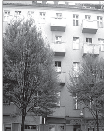
EIN Objekt in Neukölln.
